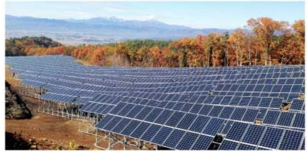
会津電力：喜多方市の雄国発電所
